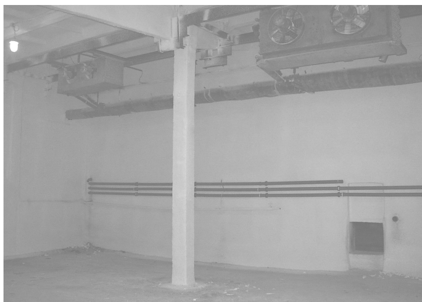
Рис.2. Герметизация камеры методом напыления пенополиуретана в холодильнике ЗАО «Острогожсксадпитомник».
