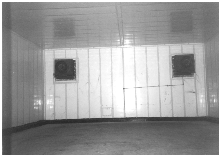
Рис.1. Герметизация камеры из панелей ППУ в холодильнике ОАО «Дубовое».
