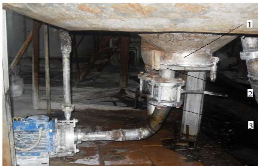
Рисунок 5.2 – Нижняя часть нейтрализатора СКЭ.
